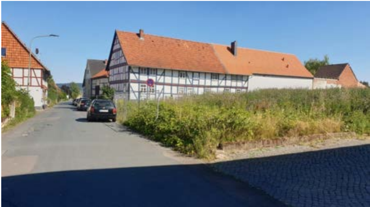
Abbildung 1: Blick von der Straße "Neustadt" auf das Plangebiet (Quelle: Aufnahme Planungsgruppe Puche Juli 2023)
