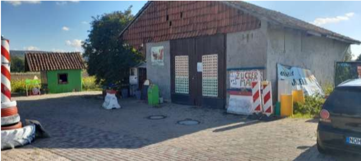
Abbildung 2 Plangebiet (nördlicher Teil) mit Blick auf Feldscheune (eigene Aufnahme)
