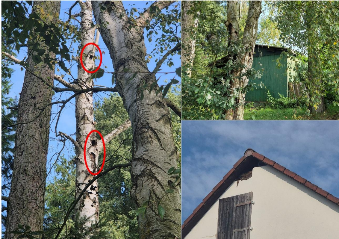
Abbildung 6: Mögliches Quartierpotenzial für Fledermäuse im Umfeld des Vorhabensgebiets. Links: in Fäulnishöhlen einer Birke nördlich des Vorhabensgebiets (ID 1) können potenziell Fledermäuse Quartier beziehen. Rechts oben: das Gartenhäuschen, das sich im selben Garten nördlich des Vorhabensgebiets befindet wie die Birken, zeigte am Dachbereich Spalten und Einflugsmöglichkeiten für kleine Fledermausarten. Rechts unten: die im Norden an das Vorhabensgebiet angrenzende Scheune ist durch die Öffnung am Giebel für Fledermäuse zugänglich. Hier können theoretisch Wochenstuben geschützter Fledermausarten vorkommen (alle Bilder B. Lüdtke am 27.08.2025).
